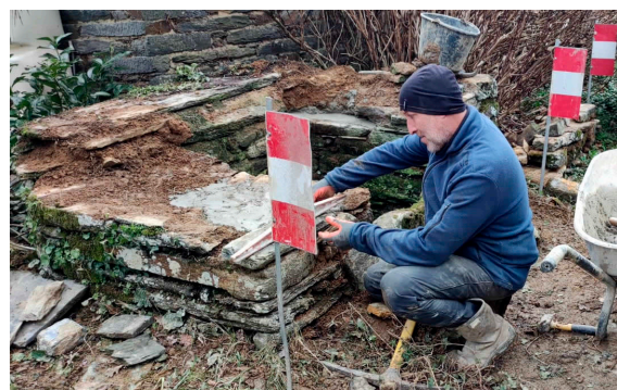
En janvier 2023, Alexandre a débuté la rénovation du puits de la Ville Erma à La Chapelle-gaceline. La photo ci-dessus prise par Jean-Yvon Castel montre le calage d'une pierre plate.
