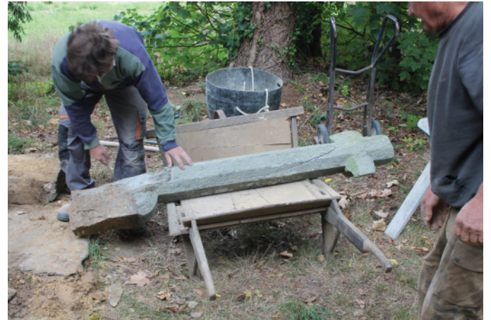
Dépose 4 (fissuration du fût de la croix)
