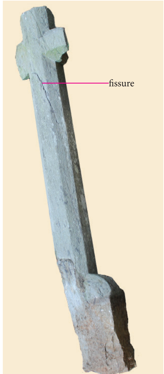
Socle fracturé et hampe fissurée
