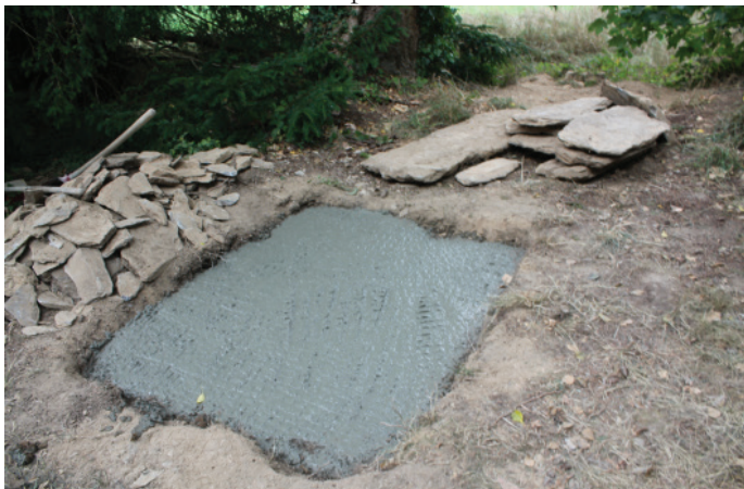
Pose d'une semelle de fondation
