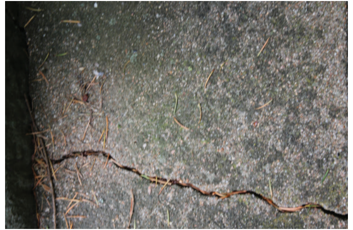
Enlèvement de la table en ciment
