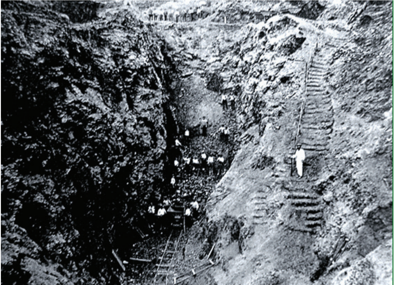
La tranchée de la mine du Haut-Sourdéac; le personnage en blanc serait Guengo de Tonquédec qui en était l'exploitant
