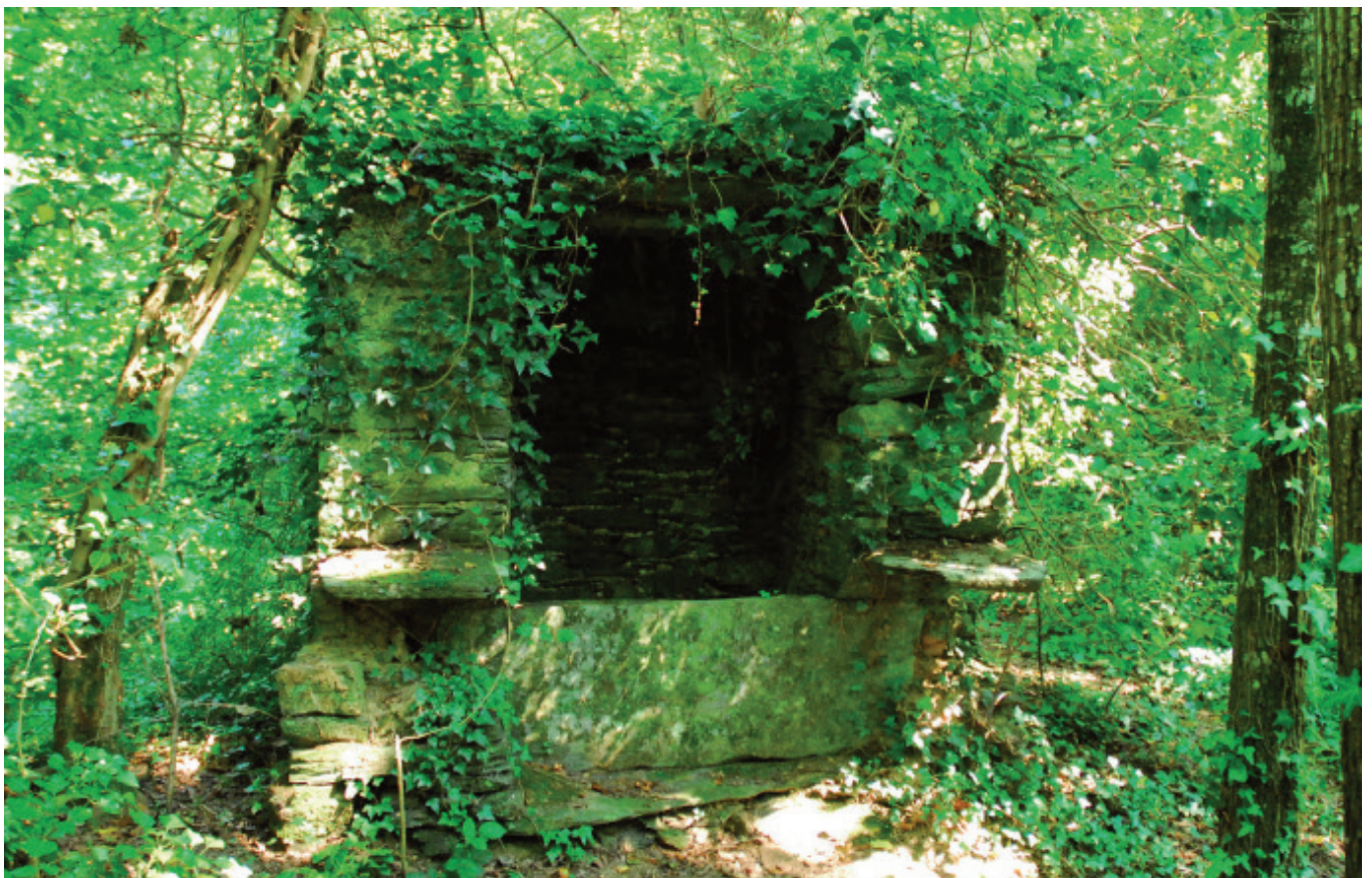
Puits sur le site de l'ancienne mine du Haut-Sourdéac
