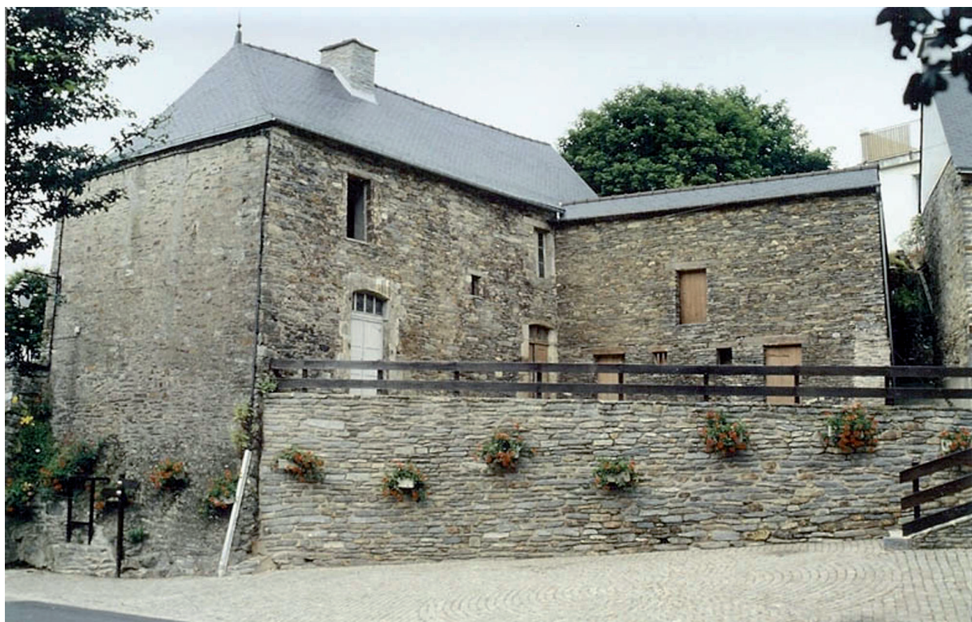
Après restauration de la toiture 1992
