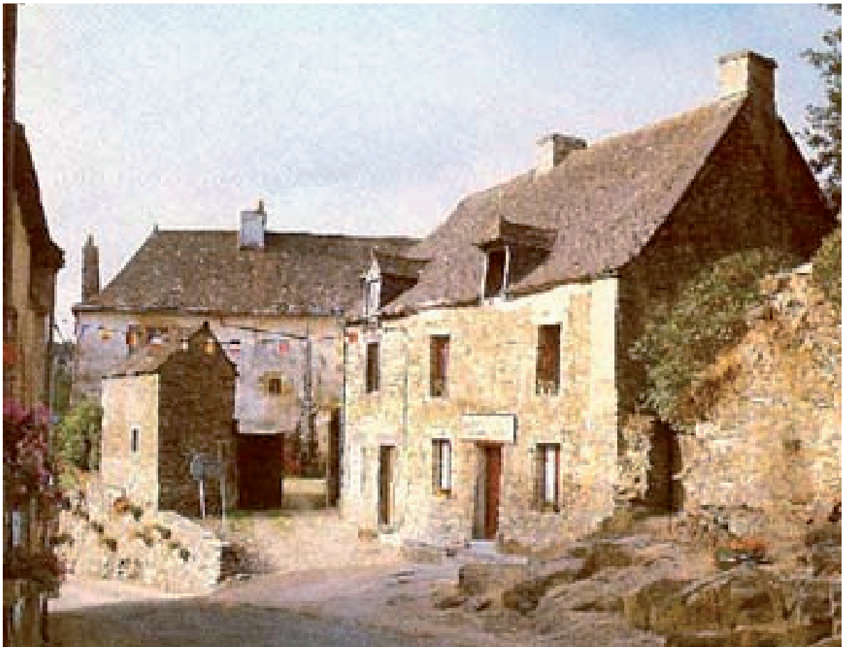
Au fond l'ancien presbytère dans les années 1970. La cheminée est est encore visible, elle sera abattue lors de la reconstruction de la toiture à coyaux.
