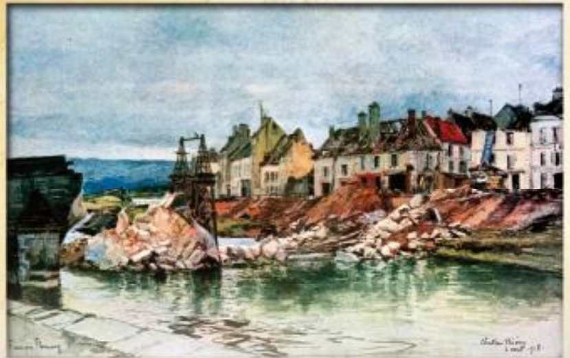
Le pont de Château-Thierry détruit, croquis de François Flameng
